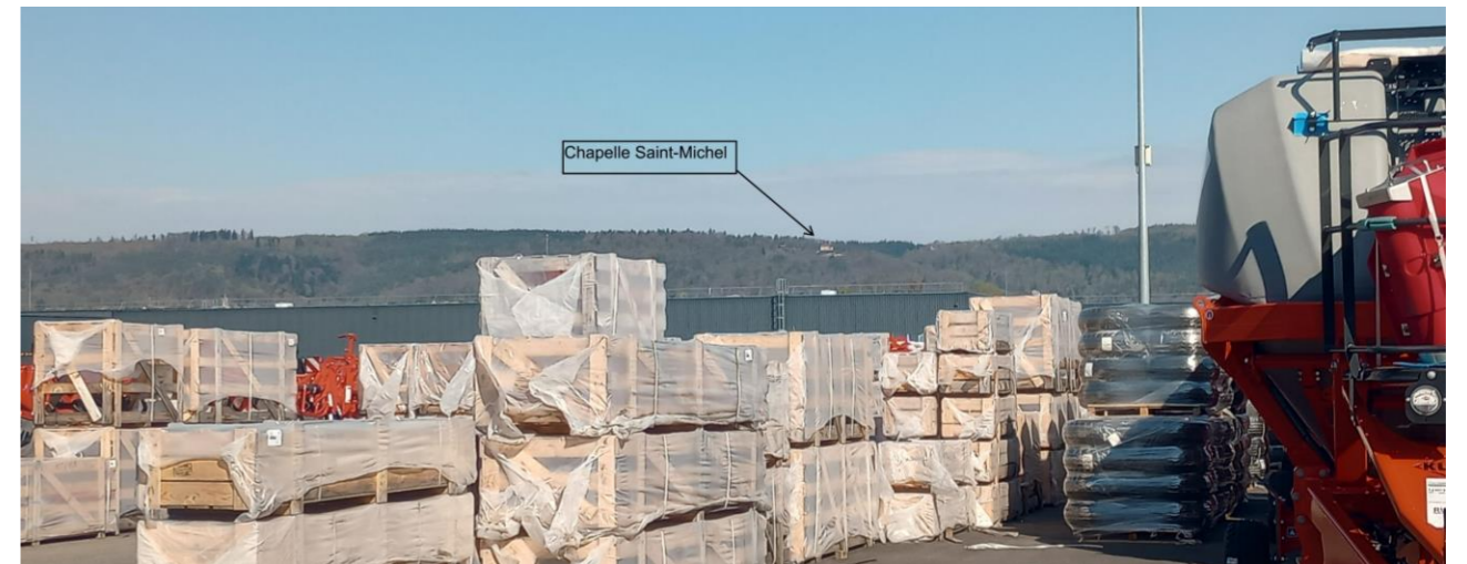
FIGURE 134 : VUE DEPUIS LE SITE DU PROJET VERS LE SITE DU MONT SAINT-MICHEL. (SOURCE : EGIS, AVRIL 2023)
