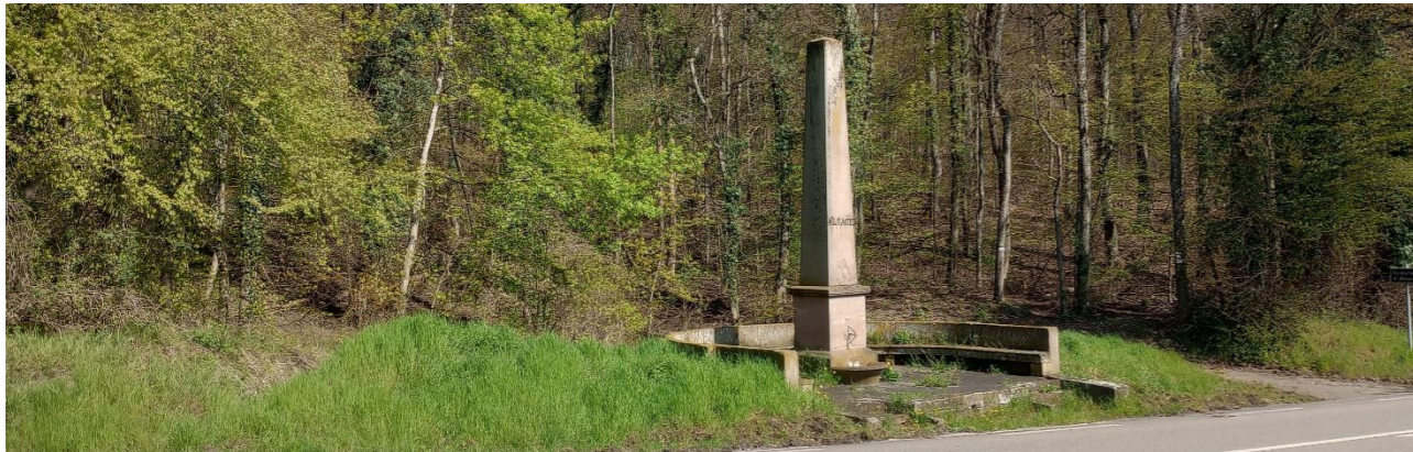
FIGURE 139 : VUE SUR LA FONTAINE MONUMENTALE AU COL DE SAVERNE (SOURCE : EGIS, AVRIL 2023)
