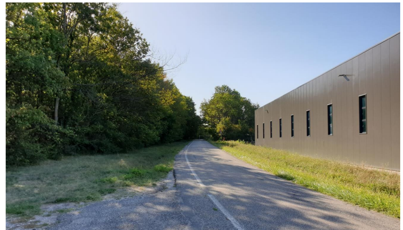
FIGURE 127 : VUE DEPUIS LE CHEMIN DU MARTLEBERG SUR LA ZONE DE PROJET À GAUCHE ET LA ZA MARTEMBERG À DROITE (SOURCE : EGIS)
