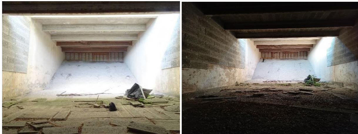
FIGURE 50 : PHOTOGRAPHIES DE LA ZONE DE SABLE DE LA ZONE DES CIBLES - © H. POUCHELLE EGIS 2019 ET 2022 (À DROITE)
