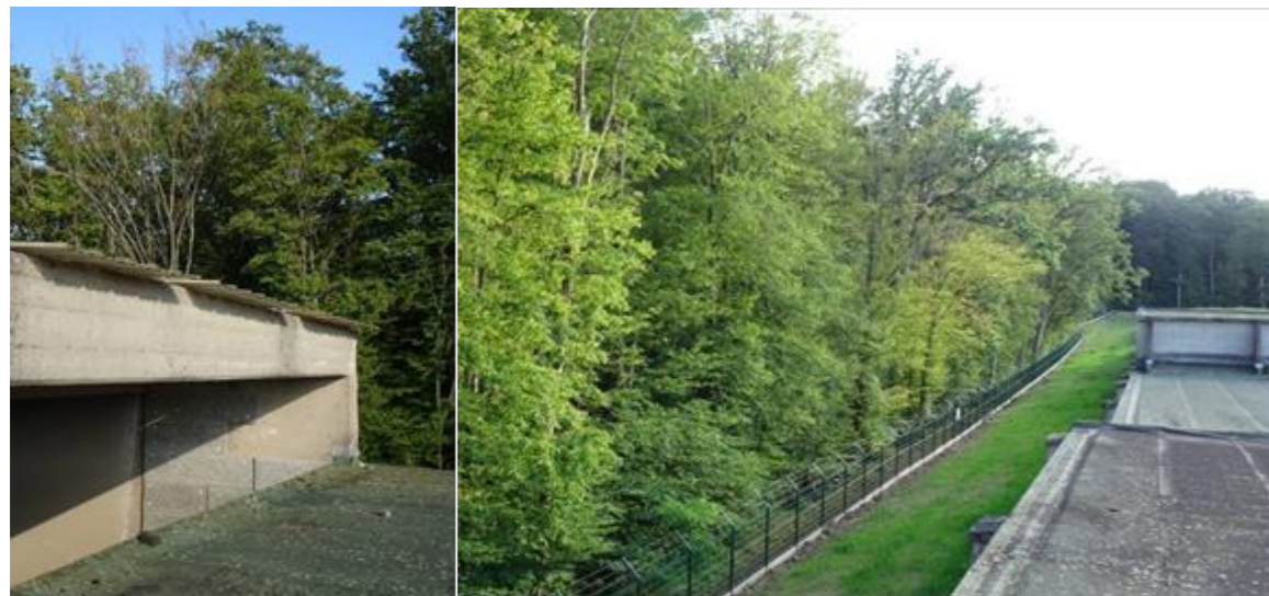
FIGURE 46 : PHOTOGRAPHIES – STAND DE TIR – ENREGISTREUR À L'ÉMERGENCE ET LISIÈRE – © H. POUCHELLE EGIS 2019
