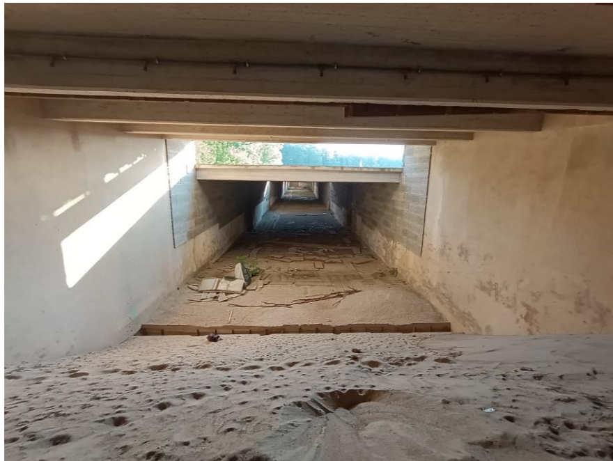
FIGURE 49 : PHOTOGRAPHIE DES ENTRÉES « AÉRIENNES » DU STAND DE TIR - © H. POUCHELLE EGIS 2022
