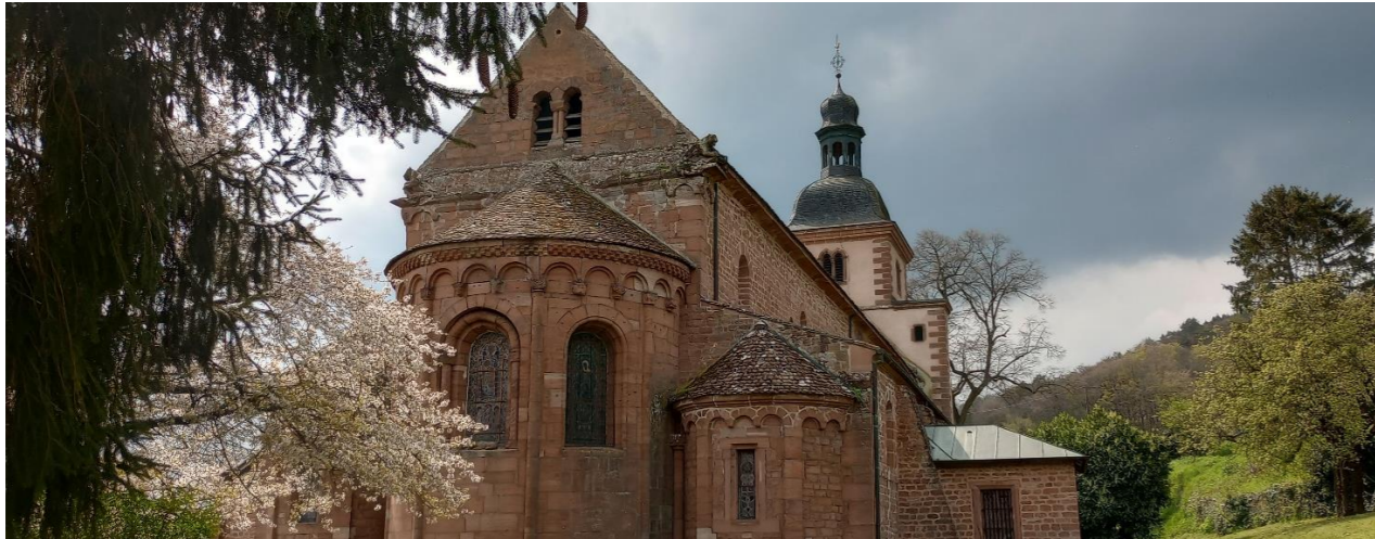
FIGURE 135 : ÉGLISE ABBATIALE À SAINT-JEAN-SAVERNE (SOURCE : EGIS, AVRIL 2023)
