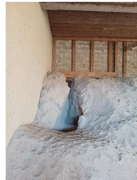
FIGURE 55 : PHOTOGRAPHIE D'UN TERRIER DANS LA ZONE DES CIBLES - © H. POUCHELLE EGIS 2022
