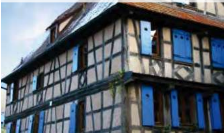
Corps de ferme, utilisation du colombage présent sur l'ensemble du territoire - Ringendorf
