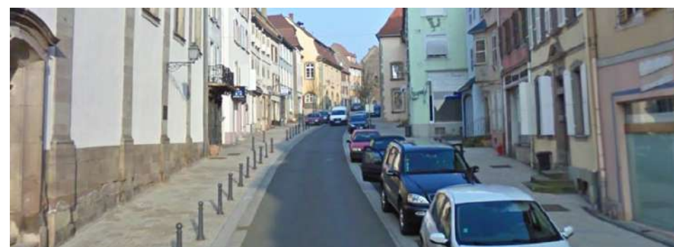
Aménagements piétons à Sarre-Union
